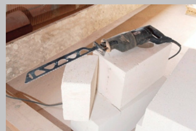
Резка в аэрированного бетона
